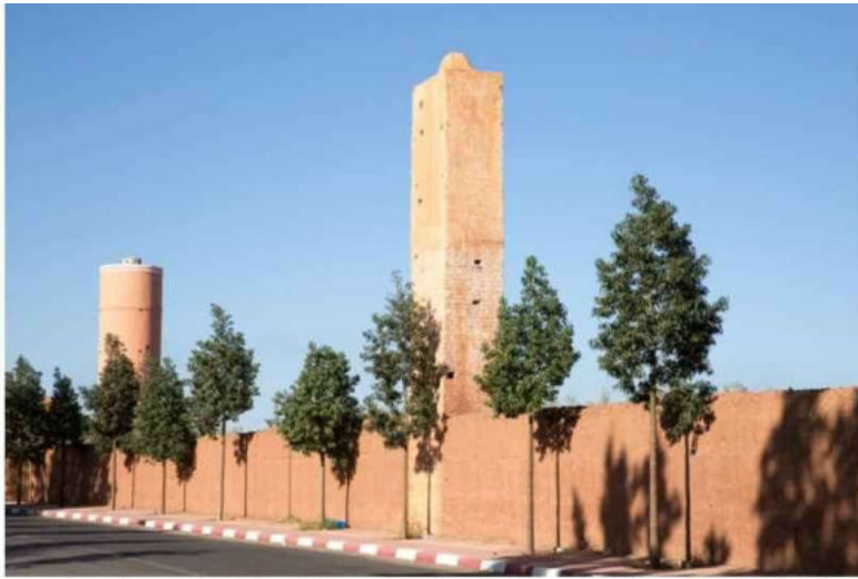
Les syphons en série de Tamesloht, une alternative astucieuse pour transférer de l'eau d'un bord à un autre de la vallée (90 mots)
